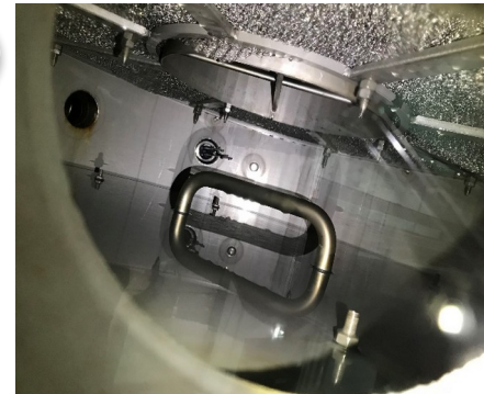
Tropfenabscheider, Demister, 2 Jahre Betrieb
