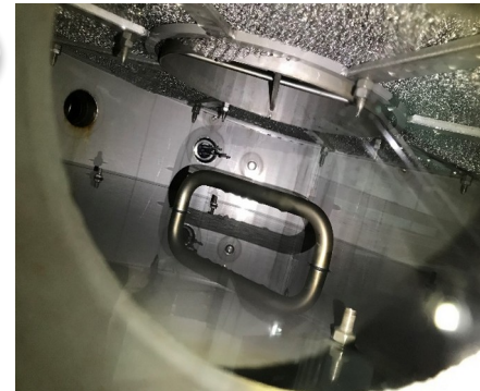
Tropfenabscheider, Demister, 2 Jahre Betrieb
